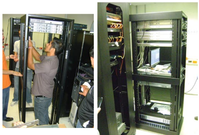
Durante el proceso de armado e instalación del equipo
