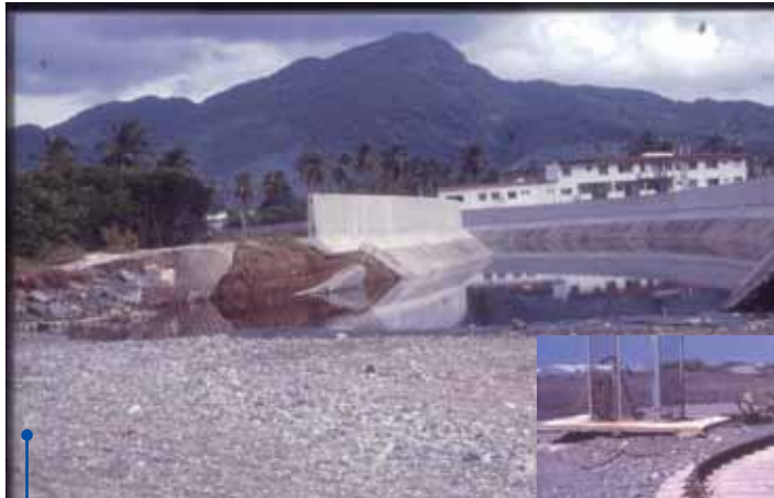
Canal hacia la Presa "La Villita"
